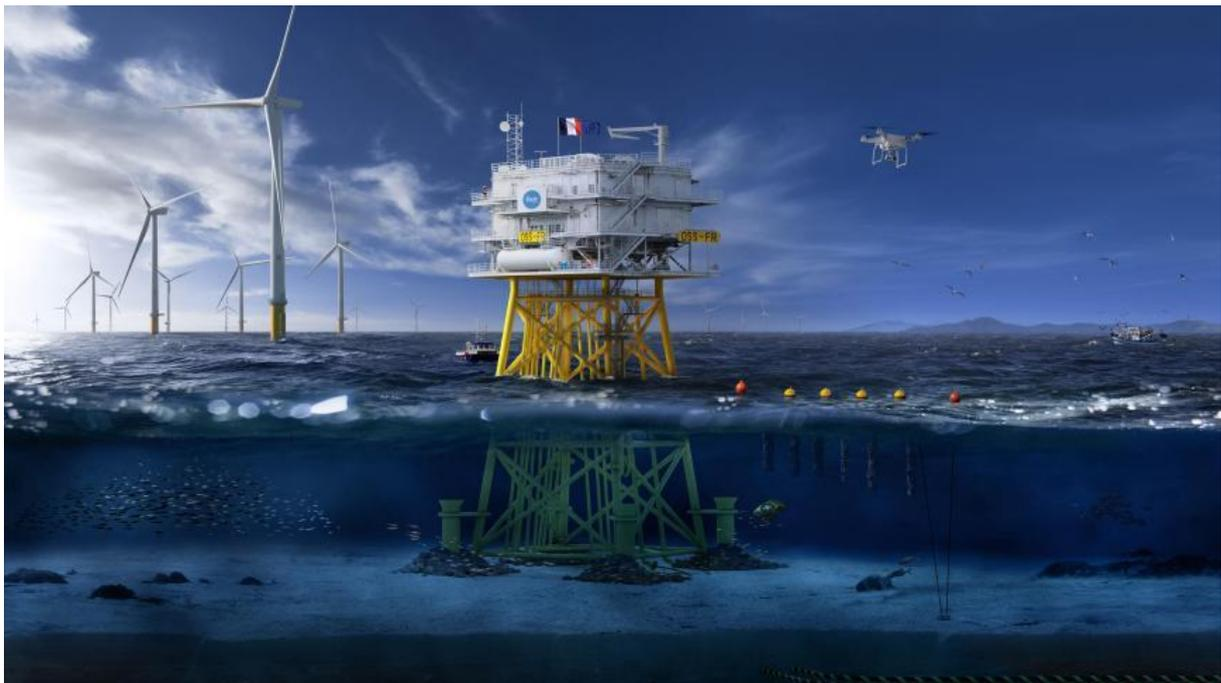
Une certitude: les éoliennes seront posées sur des monopieux enfoncés dans le fond marin et seront raccordées au poste électrique en mer. Photo RTE poste électrique
