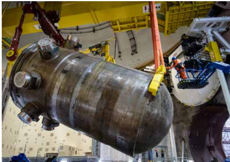
HPC - Installation de la cuve de la tranche 1
