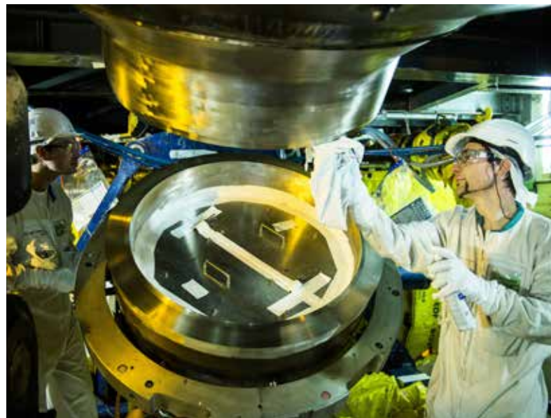
Opération de remplacement de générateurs de vapeur Blayais
