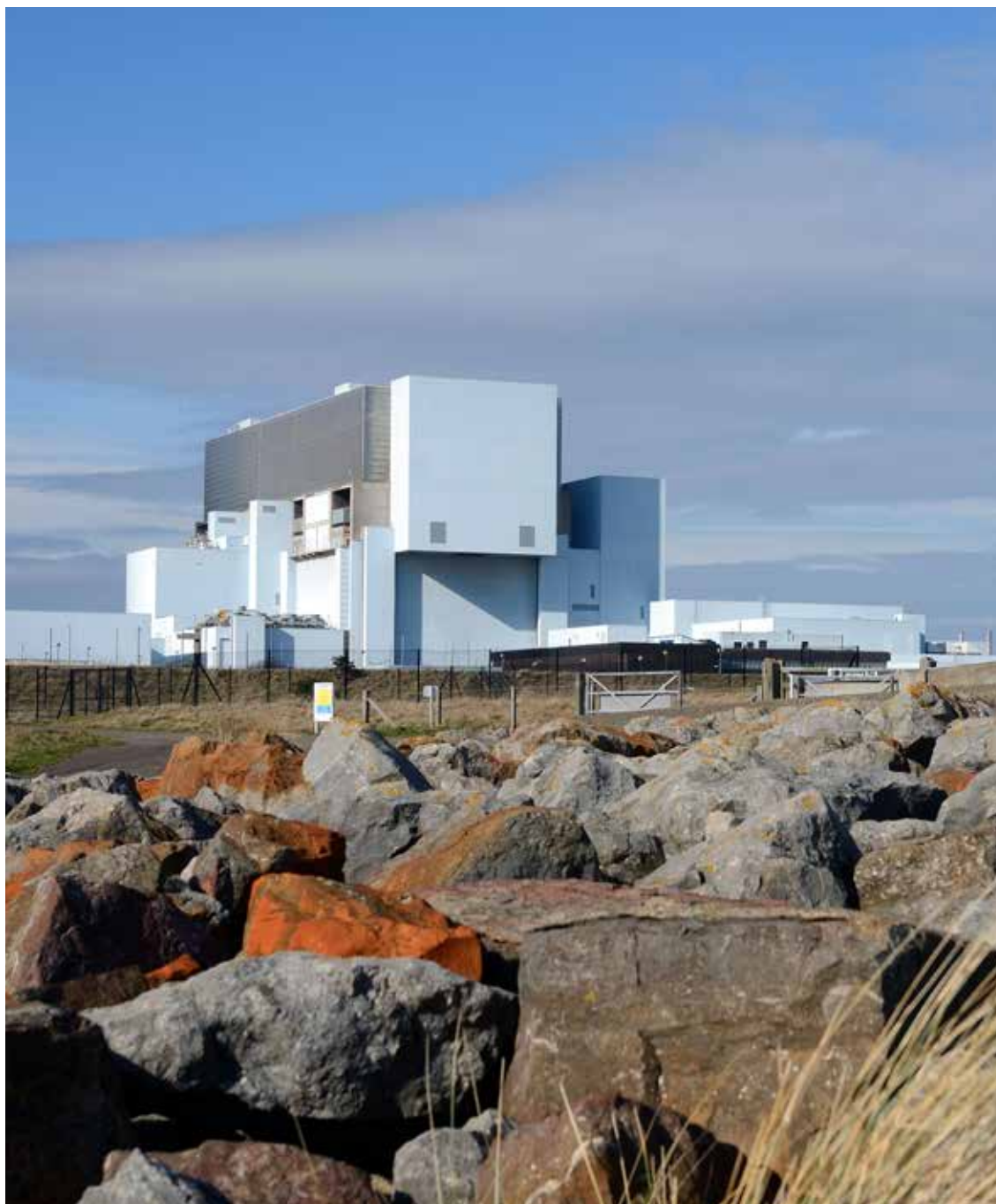
Centrale de Torness
