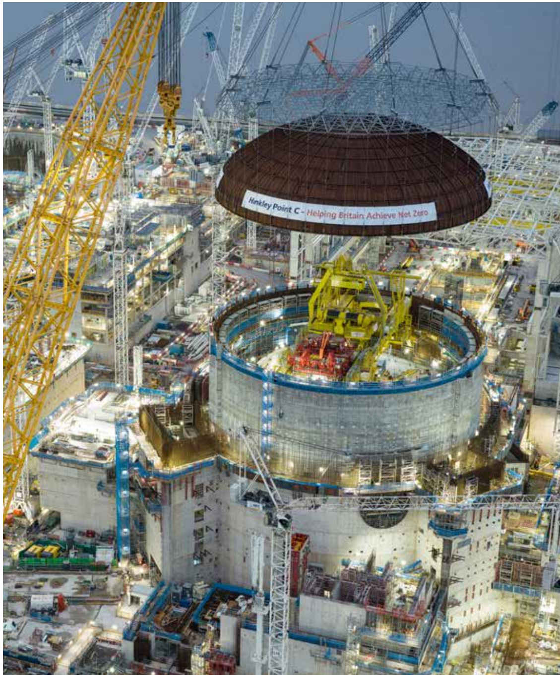
Pose du dôme du réacteur n°1 HPC
