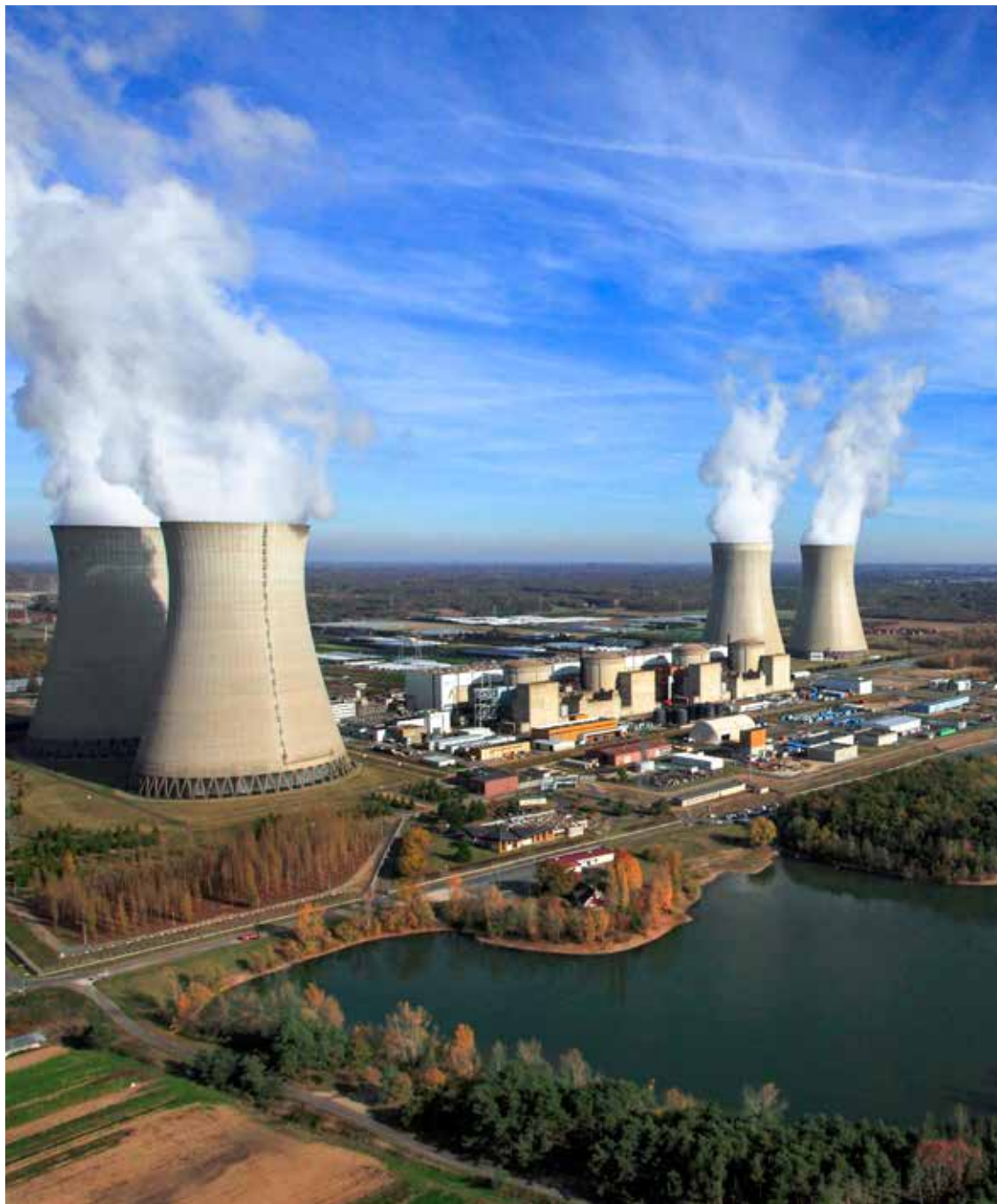
Centrale de Dampierre-en-Burly
