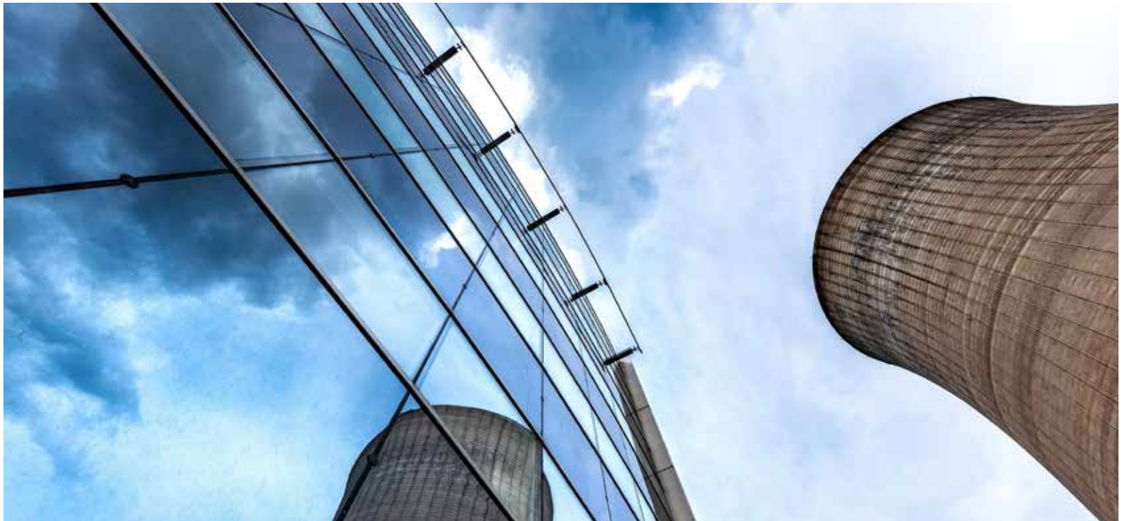
Centrale de Dampierre-en-Burly
