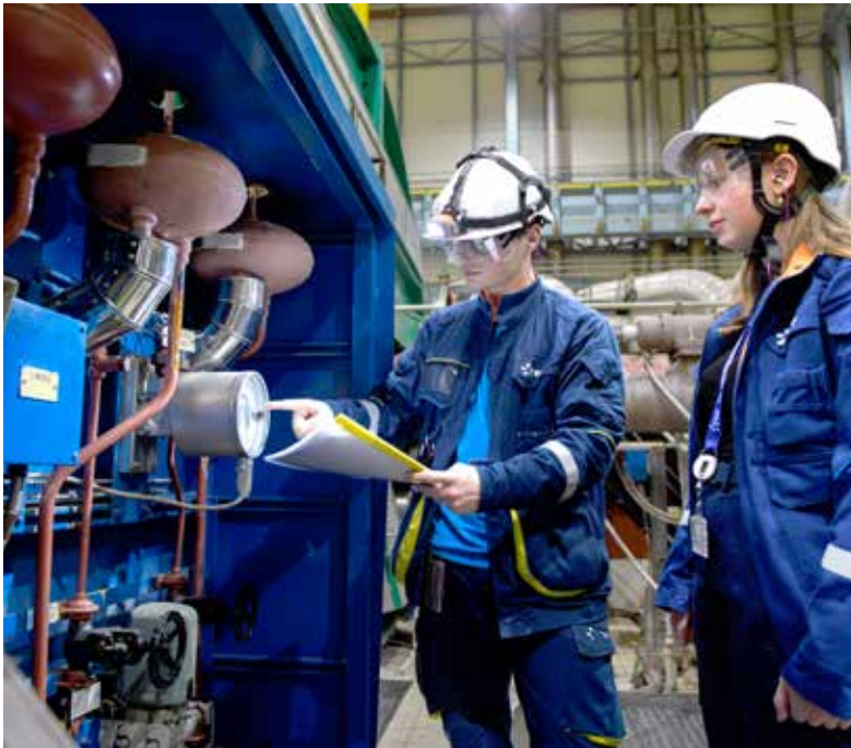
Intervention d'automaticiens en salle des machines Flamanville 1&2
