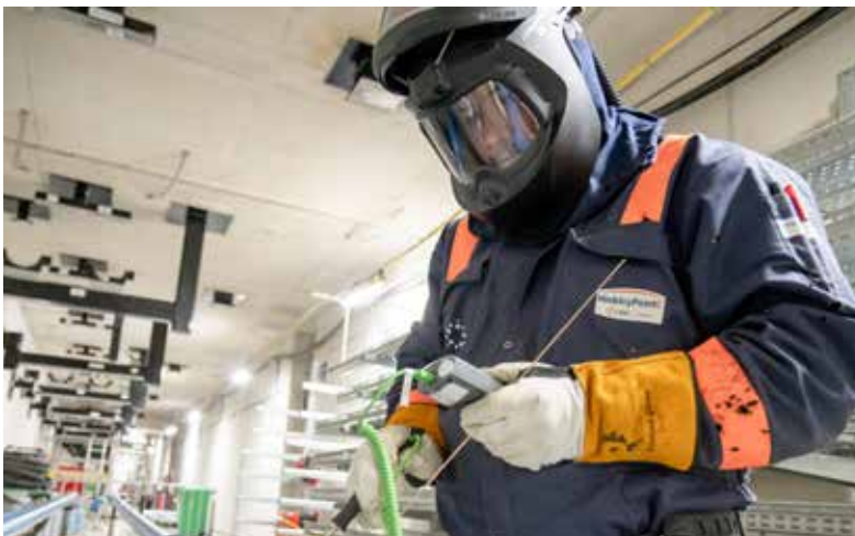
Montages électromécaniques HPC
