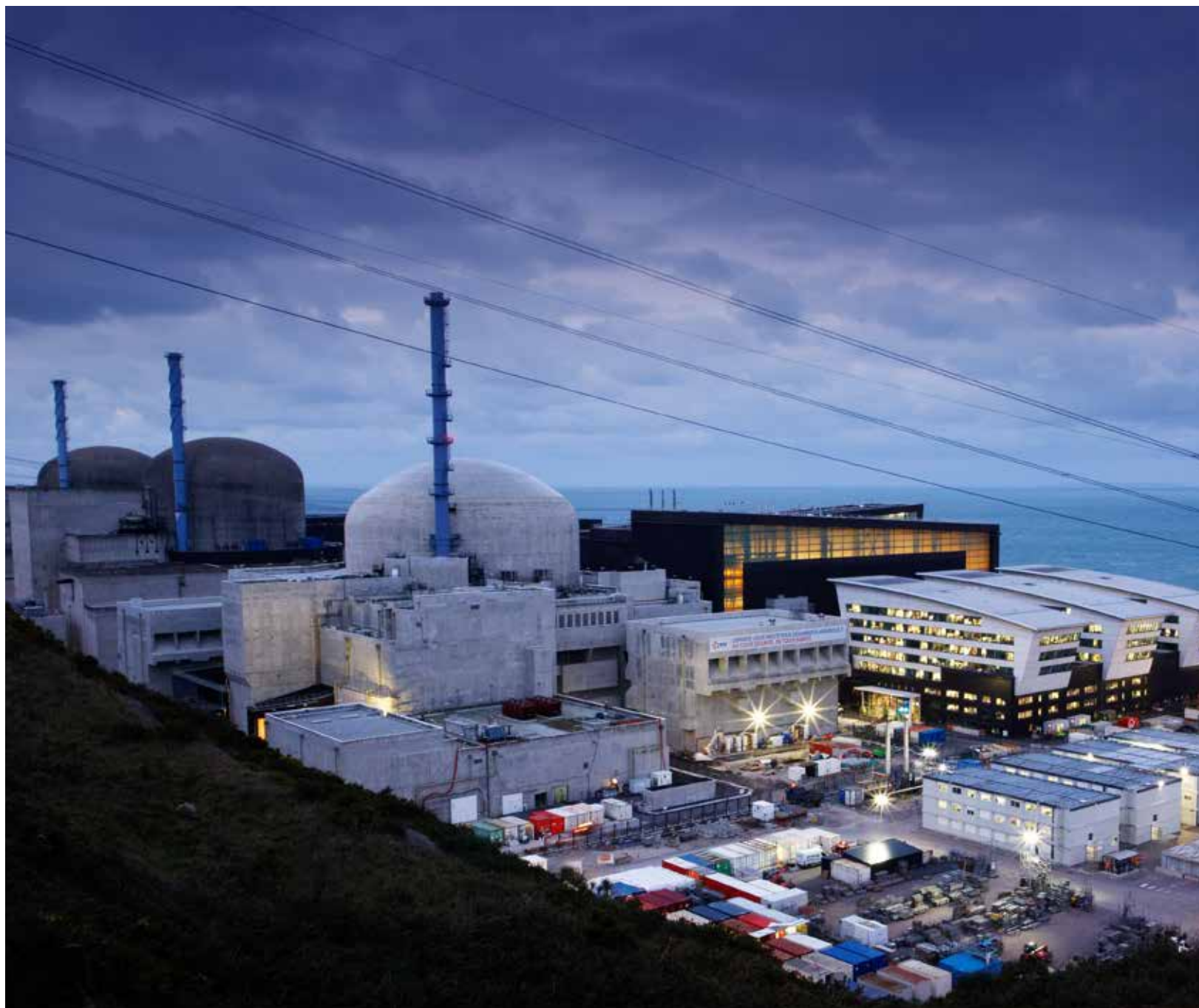
Centrale de Flamanville 3
