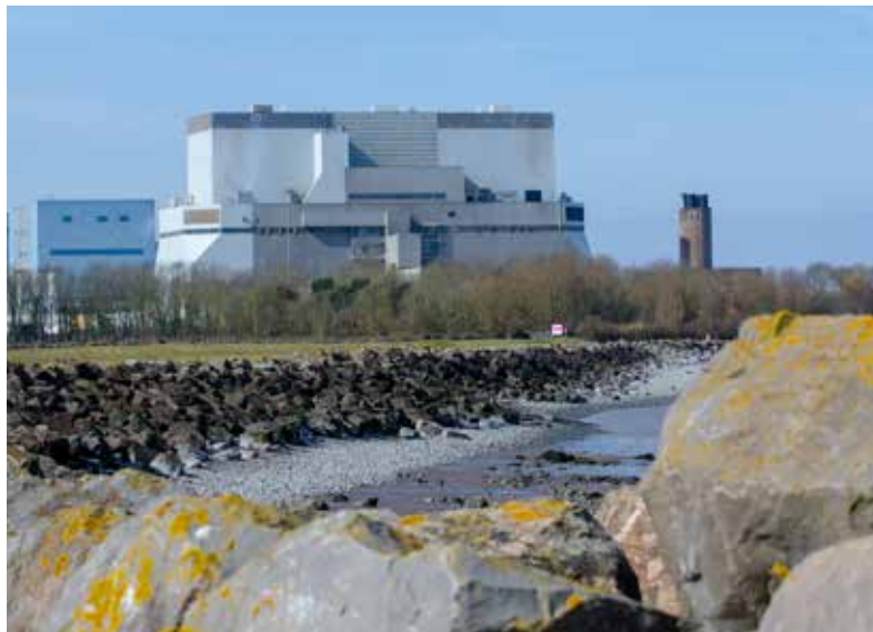
Centrale de Hinkley Point B
