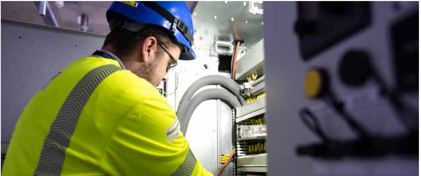
Activité de montage électrique HPC
